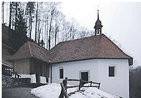
Obere Ranftkapelle, links die angebaute Klausur des Bruder Klaus
